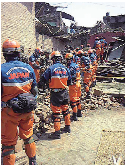
手作業によるガレキ除去
